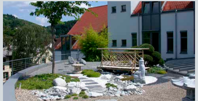
Abb. 5/2: Dachterrasse mit Intensiv-Begrünung
