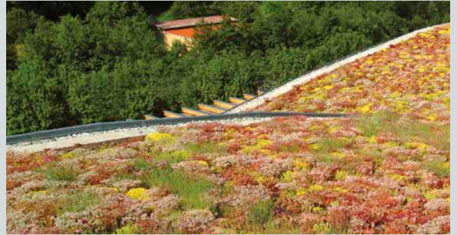
Abb. 5/1: Dach mit Extensiv-Begrünung
