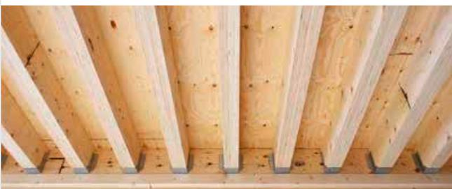
Entwickelt nach dem Vorbild der Natur, vereinen STEICO Stegträger und STEICO *LVL* Furnierschichtholz Belastbarkeit und Stabilität mit höchster Effizienz. Dank dem geringen Eigengewicht, der hohen Tragfähigkeit und dem schlanken Design entstehen zukunftsweisende Konstruktionen in Holzbauweise, die sich durch Gestaltungsvielfalt und höchste Sicherheit auszeichnen.
