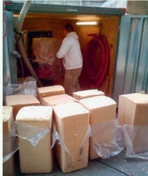
Die Ballen der Einblasdämmung werden in die Maschine eingefüllt.
